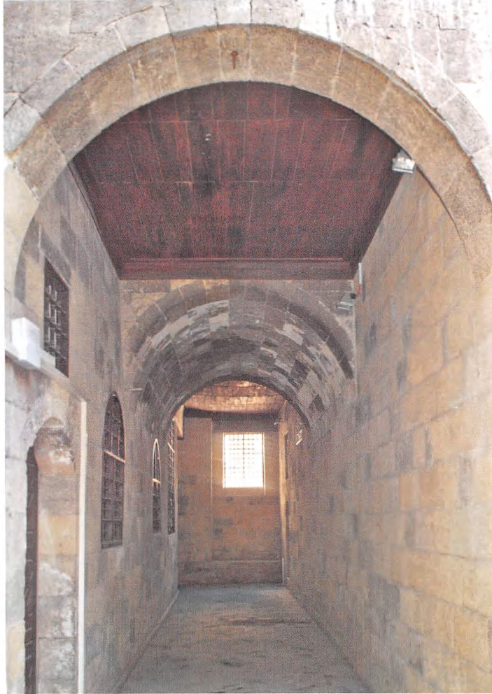
(لوحة 18) دهليز المدخل من جهة الفناء الداخلي باتجاه الخارج.
